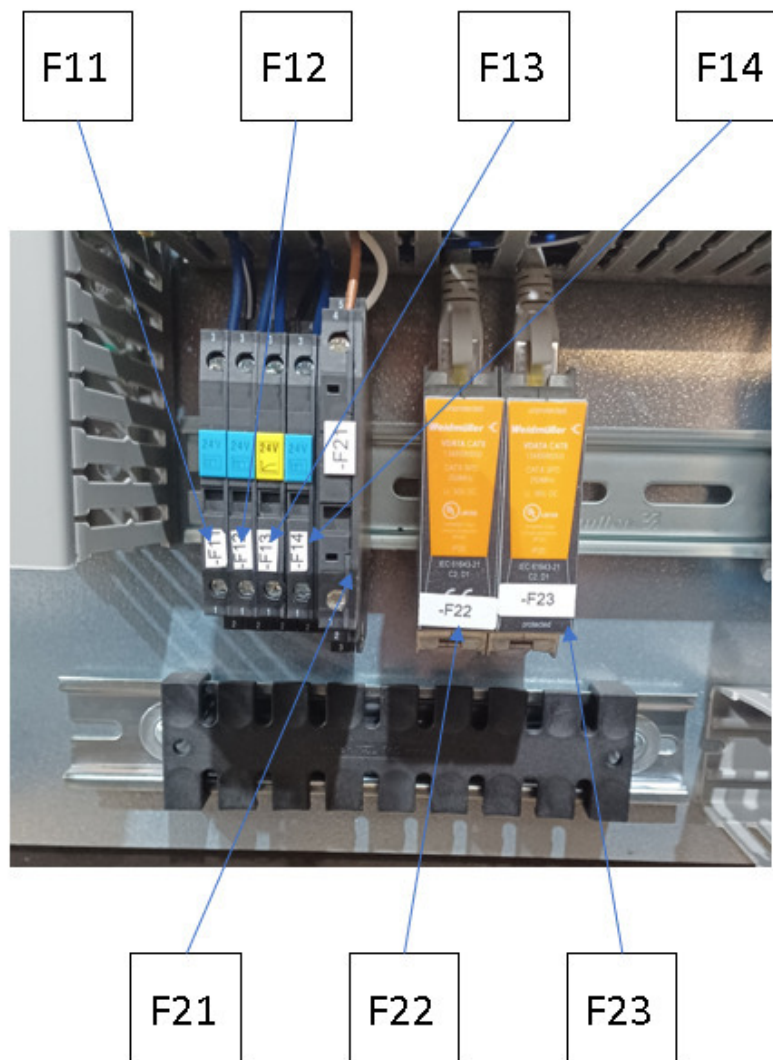
Illustration 21. Anschluss — Kommunikation und Signale — AA1, AA2
