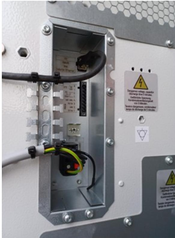
Abbildung 40. Anschließen der Raumklimatisierung
