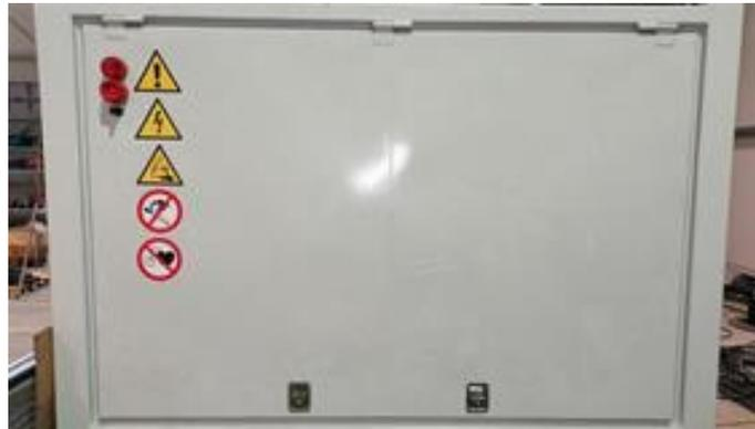
Die Wartungsklappen sind am Batterie-Container eingebaut und werden über Gasdruckfedern verschlossen.
