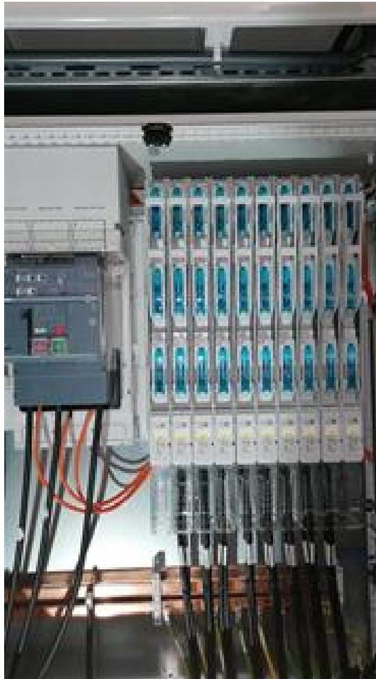
Abbildung 5. Niederspannungshauptverteilung
