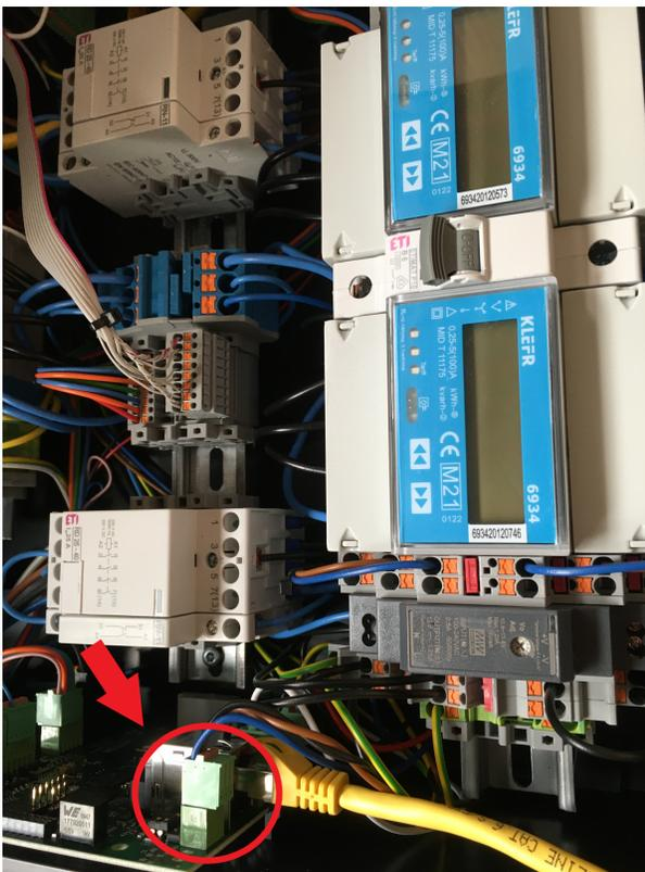
Abbildung 3. Steckverbindung Zähler
