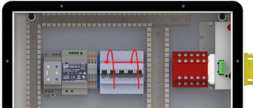
Abbildung 17. Einsichern der Leitungsschutzschalter in der AVU
